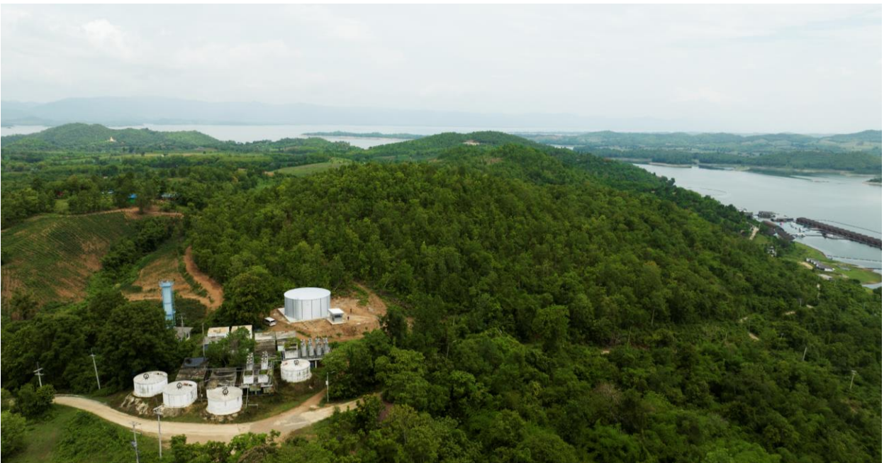
RCT-360-64 (1,058,423 ลิตร) ต.ท่ากระดาน จ.กาญจนบุรี ปรับปรุงระบบประปาเดิม ใช้ร่วมกับถังคอนกรีตเดิม
