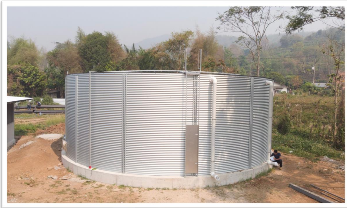
ประปาแม่อาয় รุ่น RCT-275-43 (538,055 ลิตร) อ.แม่อาয় จ.เชียงใหม่ เส้นผ่าศูนย์กลาง 12.623 ม. สูง 4.30 ม. ถังเก็บน้ำขยายแรงดัน เพื่อช่วยเหลือพื้นที่ห่างไกลจากจุด จ่ายน้ำเพื่อช่วยพื้นที่ห่างไกล
