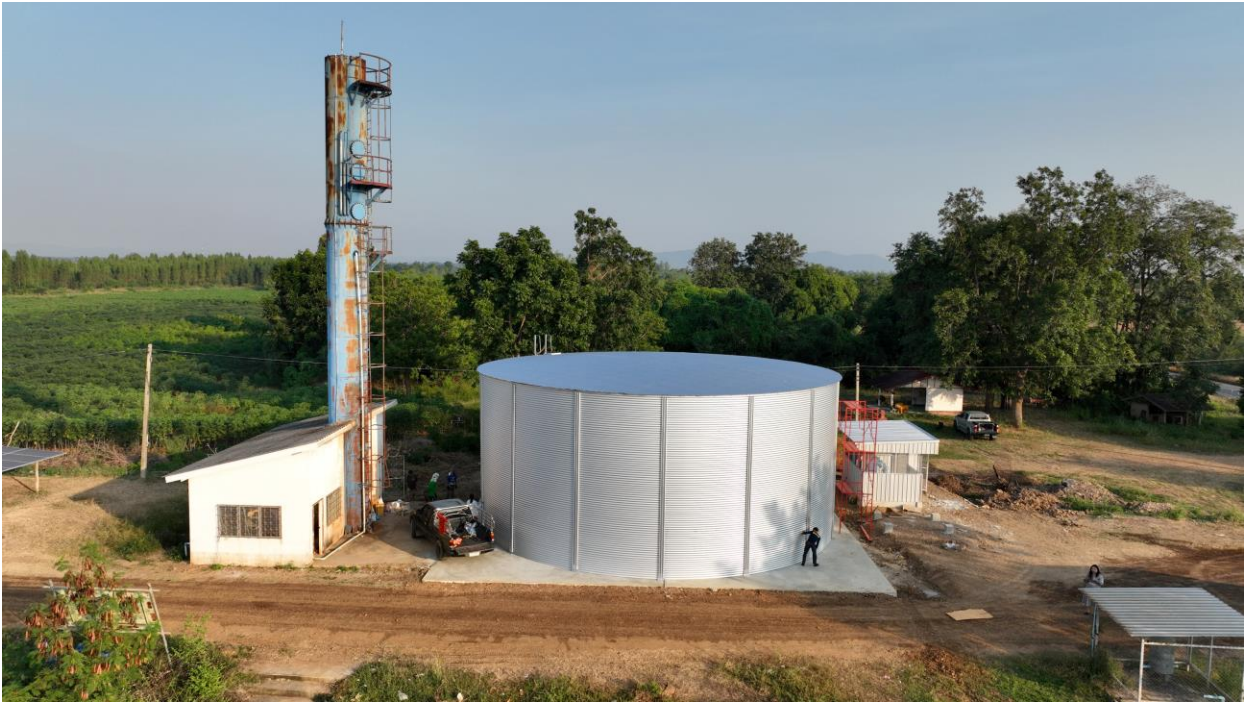
RCT-360-64 (1,058,423 ลิตร) บ้านหนองขบ ต.หนองนกแก้ว จ.กาญจนบุรี ปรับปรุงระบบประปาเดิม
