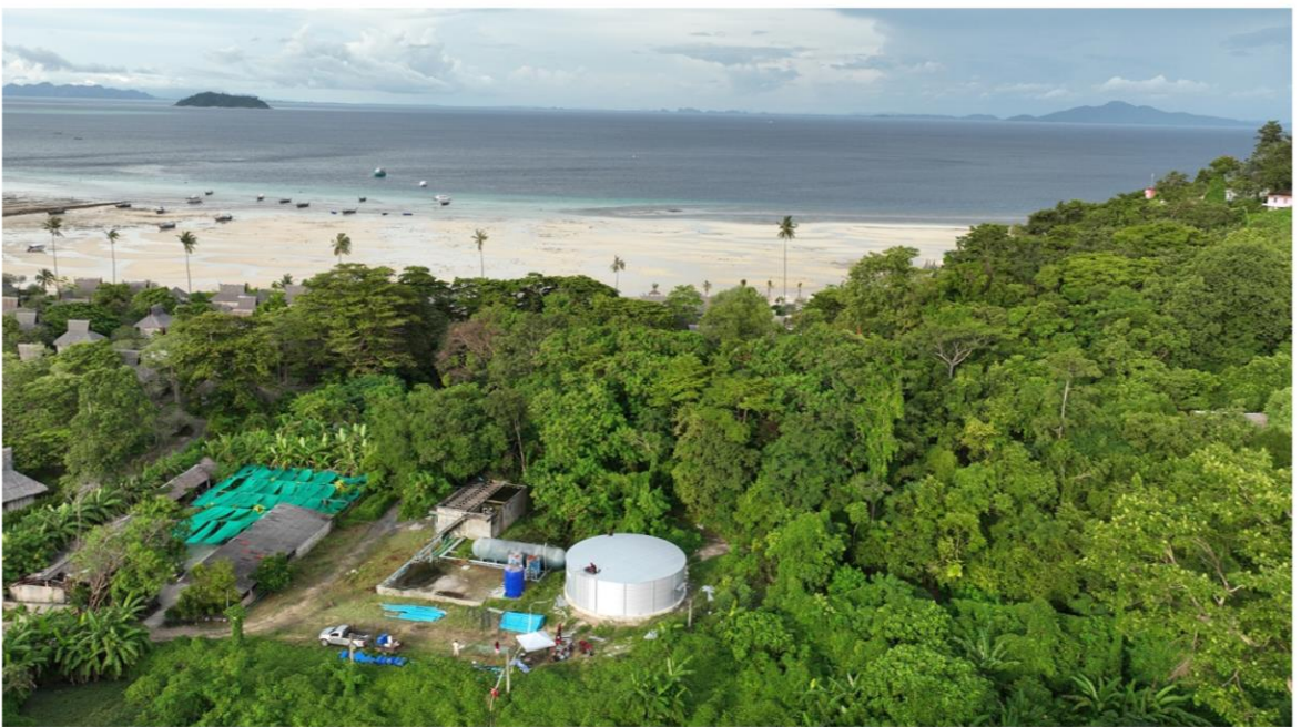
เกาะพีพี รุ่น RCT-275-36 (450,366 ลิตร) จ.กระบี่ เส้นผ่าศูนย์กลาง 12.623 ม.สูง 3.6 ม. สำหรับน้ำใช้ในโรงแรมเกาะพีพี ติดตั้งใกล้ทะเลแต่ไม่มีปัญหา เพราะเรามีตัวเสียสละประจุกันสนิม
