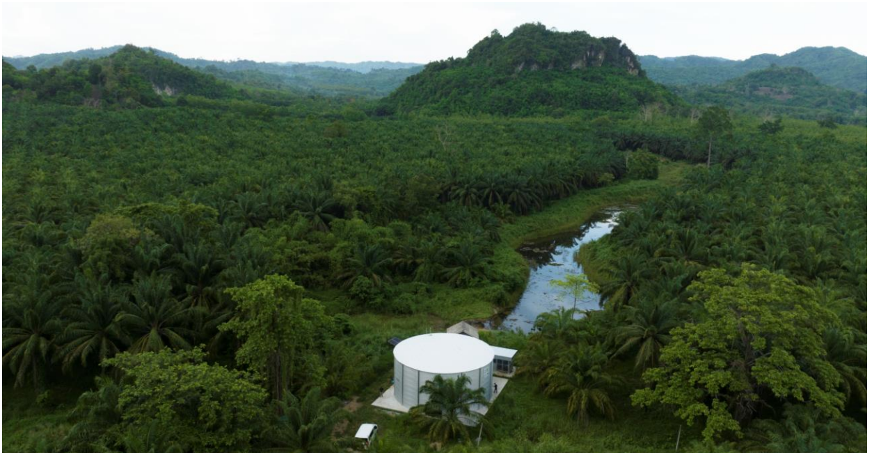
RCT-360-64 (1,058,423 ลิตร) ต.หินดาด จ.กาญจนบุรี ปรับปรุงระบบประปาเดิม
