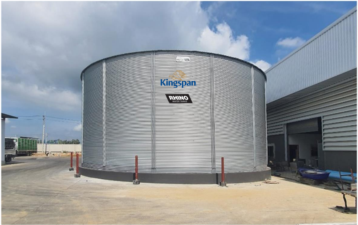
ไฟโรจน์ โพลทรีย์ ฟู๊ด RCT320-64 (929,264 ลิตร) บ้านกร่าง จ.พิษณุโลก เส้นผ่าศูนย์กลาง 13.594 m H: 6.40 m ติดตั้งไฟโรจน์ ฟาร์ม จ.พิษณุโลก ใช้สำหรับน้ำดื่มสะอาด เพื่อใช้ในการผลิต ตามมาตรฐานอเมริกา NSF61 สำหรับฐานที่ต้องการลดต้นทุนก่อสร้าง สามารถทำ ได้โดยมีคานคอนกรีตสำหรับรับผนังถังเก็บน้ำเท่านั้น ก็เพียงพอ
