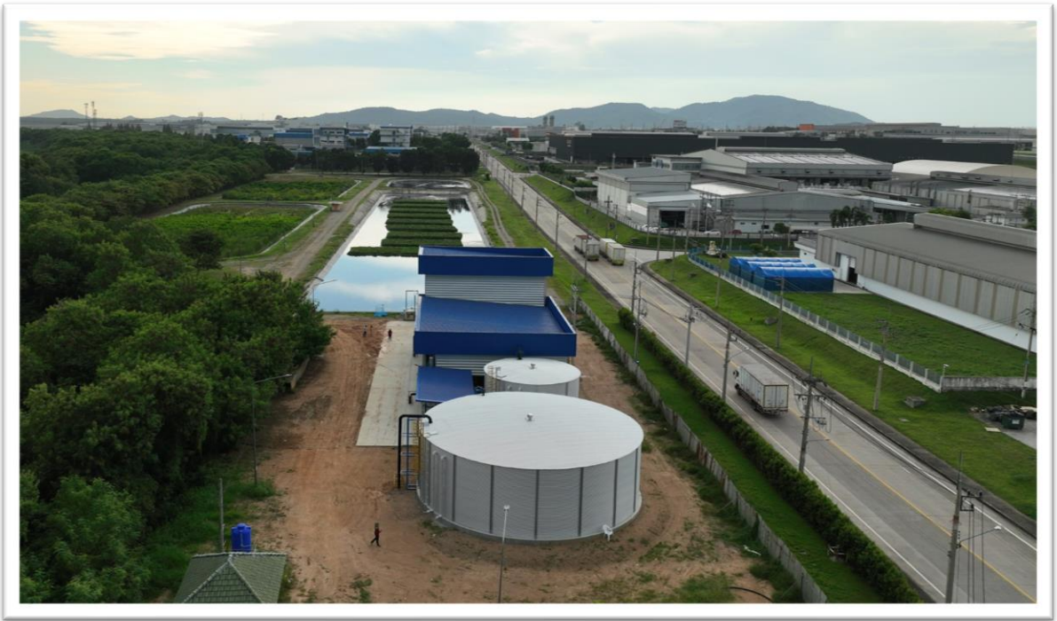
WHA-E1 RCT-470-50 (1,069,891 ลิตร) อีสเทิร์นซีบอร์ด อ.ปลวกแดง จ.ระยอง เส้นผ่าศูนย์กลาง 16.507 m H: 5 m สำหรับน้ำ RO และน้ำดิบ ในศูนย์ควบคุมระบบบำบัดน้ำเสีย ติดตั้งภายในนิคมอุตสาหกรรม
