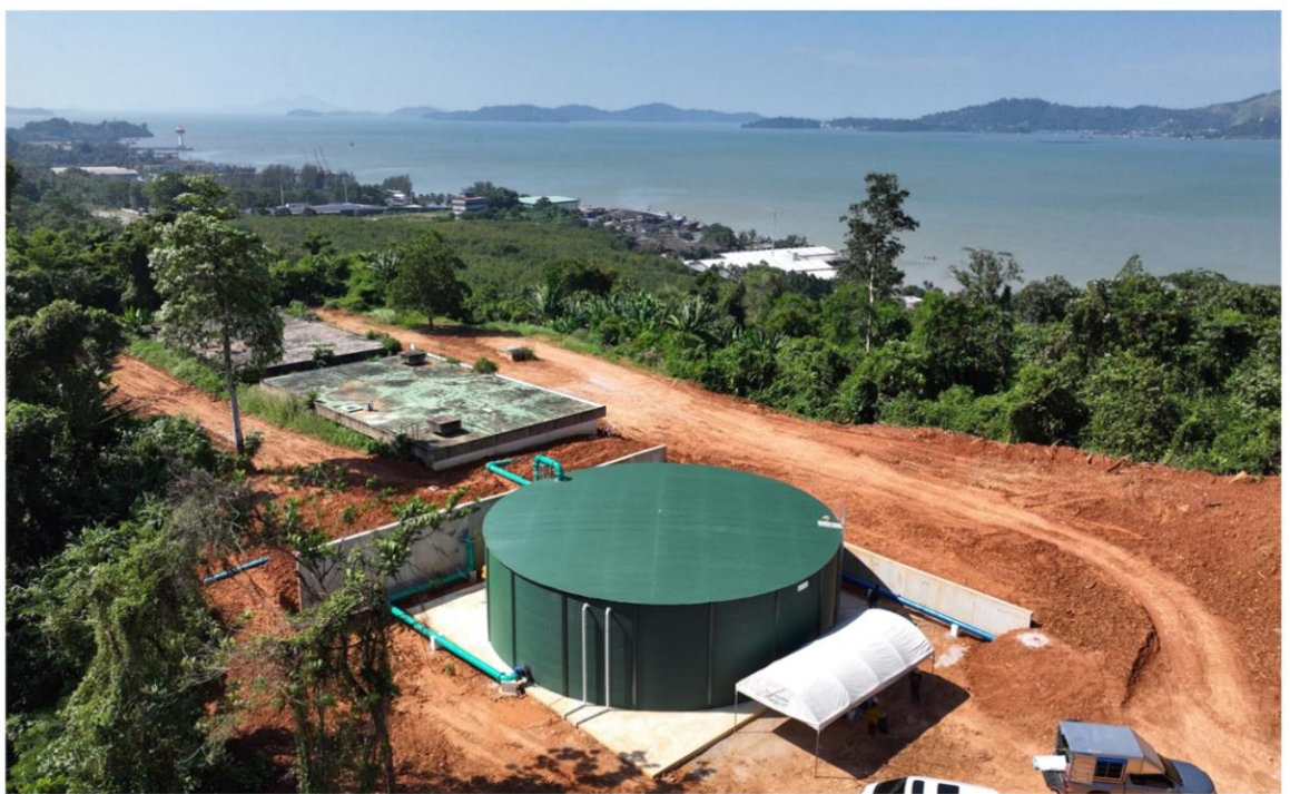
การประปาส่วนภูมิภาค RCT-470-50 (1,069,891 ลิตร) จ.ระนอง เส้นผ่าศูนย์กลาง 16.507 m H: 5 m สำหรับน้ำดื่ม จ.ระนอง เป็นถังสีเขียวเพื่อให้เข้ากับบรรยากาศ บนภูเขา และเป็นสเปกคลิน คัลเลอร์บอร์น สำหรับทนการกัดกร่อนสูงในพื้นที่ใกล้ทะเล
