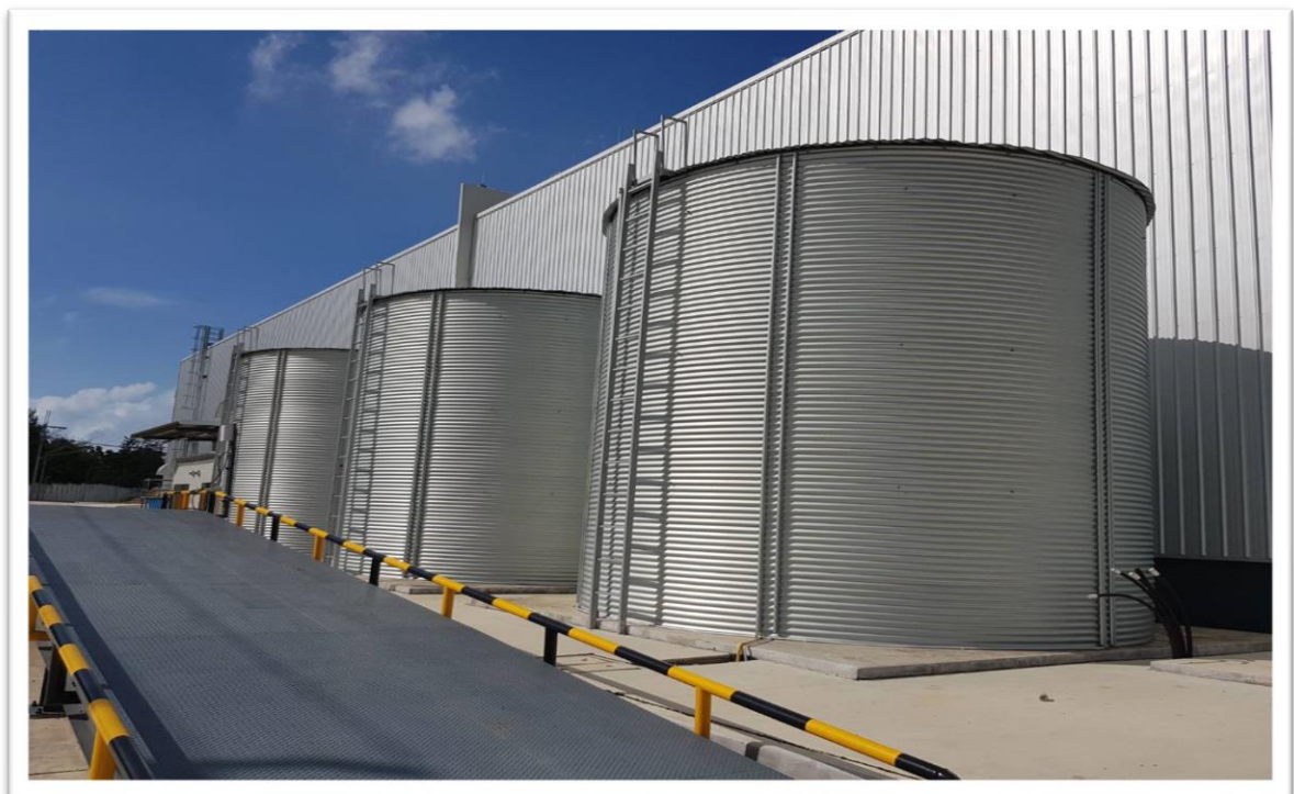
Reaxo Pharma รุ่น RCT-160-57 (152,013 ลิตร) จ.ระยอง เส้นผ่าศูนย์กลาง 5.826 ม. สูง 5.7 ม. โรงงานผลิตยา ถังน้ำมาตรฐานออสเตรเลีย AS/NZS4020 และ มาตรฐานอเมริกา NSF61
