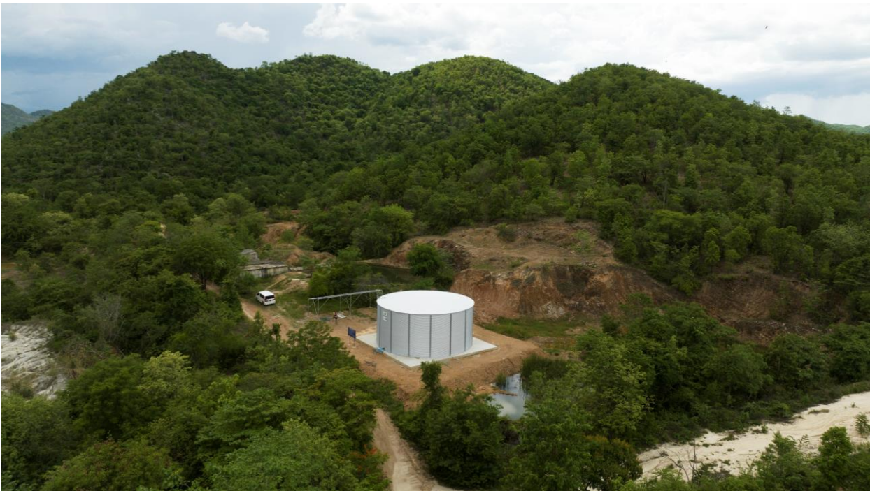
RCT-360-64 (1,058,423 ลิตร) บ้านเขาพุล้อม ต.วังดั่ง จ.กาญจนบุรี ปรับปรุงระบบประปาเดิม
