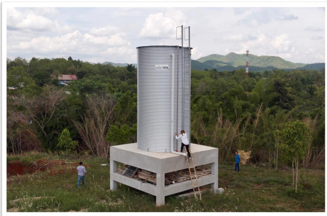
ศูนย์ปฏิบัติธรรมวัดป่าวังแก้ว รุ่น RCT-15-57 (40,136 ลิตร) อ.เด่นชัยจ.แพร่ เส้นผ่าศูนย์กลาง 3.995 ม. สูง 5.70 ม. ติดตั้งสำหรับวัดเพื่อให้ใช้แรงดันน้ำ โดยไม่ใช้ปั๊มน้ำ
